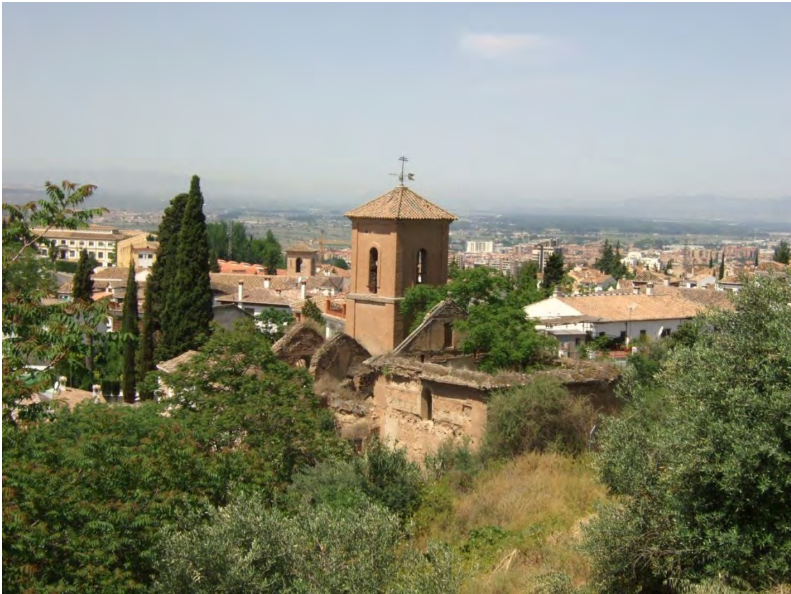
ESTADO ACTUAL DE LA IGLESIA DE SAN LUIS
