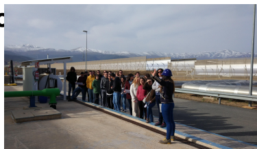
Planta Termosolar Andasol-3 (Granada)
