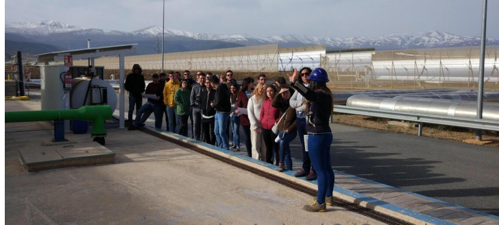
Planta Termosolar Andasol-3 (Granada)
