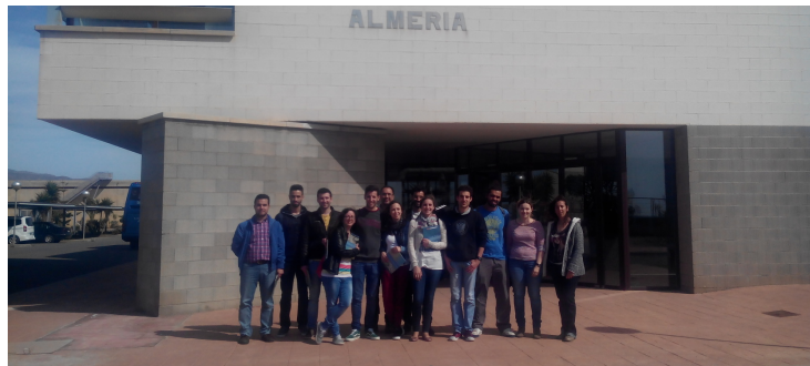
Planta Desaladora de Almería (Acciona-Abengoa Agua)
