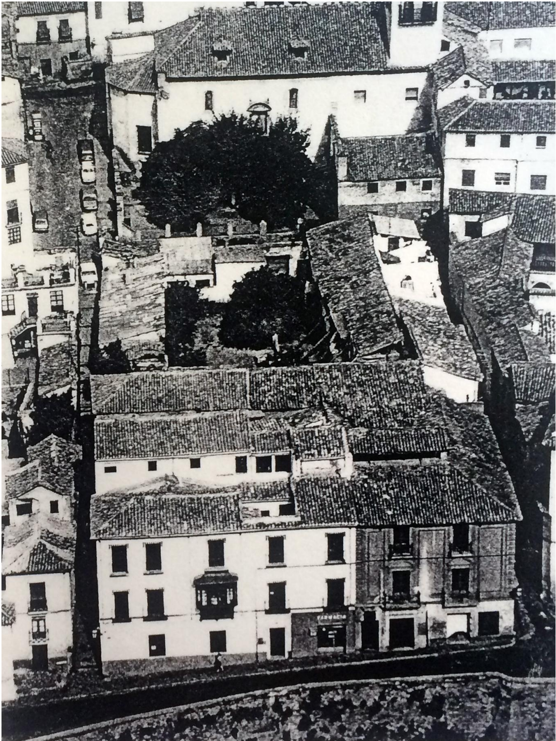
Vista del Maristán desde la Alhambra antes del inicio de la excavación
